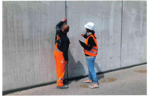
\*\*Abdichten von Boden- und Wandfugen mit einem zugelassenen säurefesten Fugensystem auf Bitumenbasis
